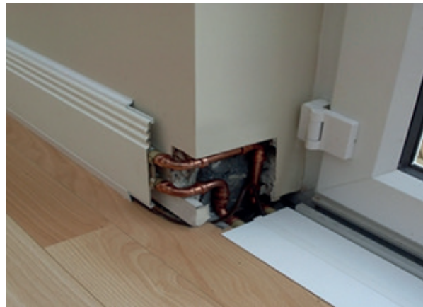
Figur 7. Ventilationsradiatorer (t.v.) och värmelister (t.h.) är två intressanta alternativ för uppvärmning av rum vid låg framledningstemperatur. Båda har utvärderats i studien och resultat visas i figur 8 nedan.
