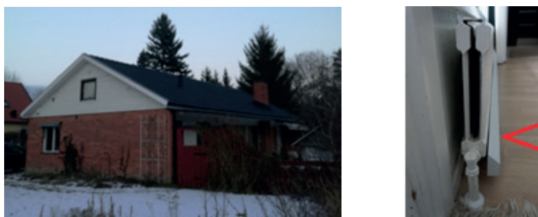
Figur 5. I detta enfamiljshus i en stockholmsförort genomfördes studien med fläktförstärkt konvektion på befintliga radiatorer för att öka värmeöverföringen vid låg framledningstemperatur. En kassett med små datorfläktar placerades under radiatoren, se pilen. Se resultat i figur 6 nedan.
