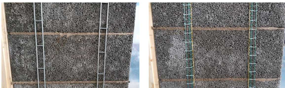
Figur 2 Förstärkning av lättklinkervägg med bistål (vänster) respektive tråd av höghållfast stål (höger). Förstärkningsputsen appliceras med spruta i efterkommande steg.
