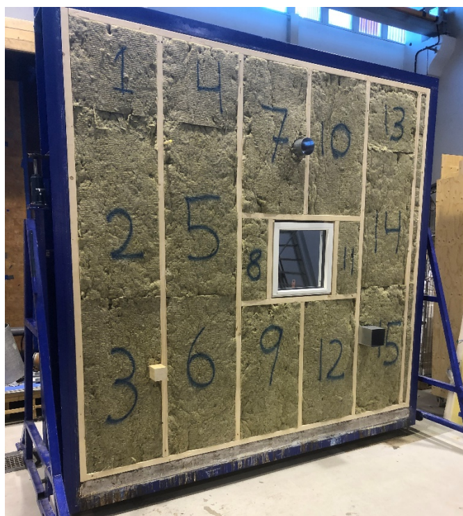
Bild 2. Provvägg före montage av folie.
