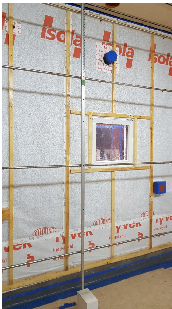
Bild 4. Provvägg monterad i kammaren för regn under samtidig pulserande vindbelastning.
