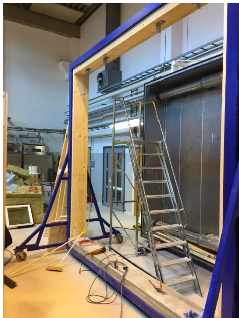
Bild 1. Provvägg under uppbyggnad.
