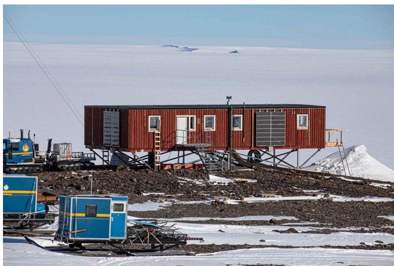
Figur 1. Huvudbyggnaden på Wasastationen 2020.
