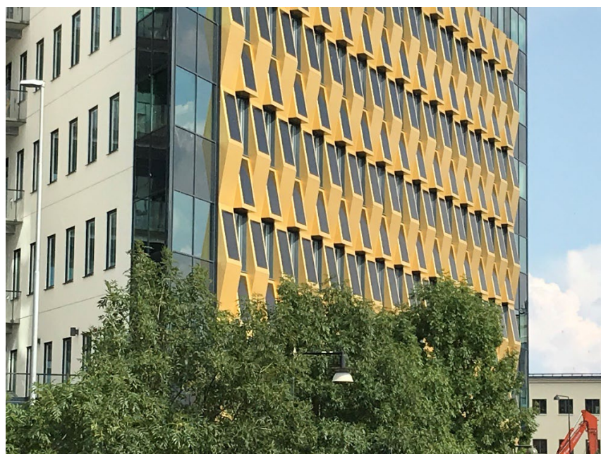
Figur 2 Exempel på solcellsfasad där solcellerna inte placerats vertikalt (Citypassagen Örebro/Castellum, Foto: David Larsson)
