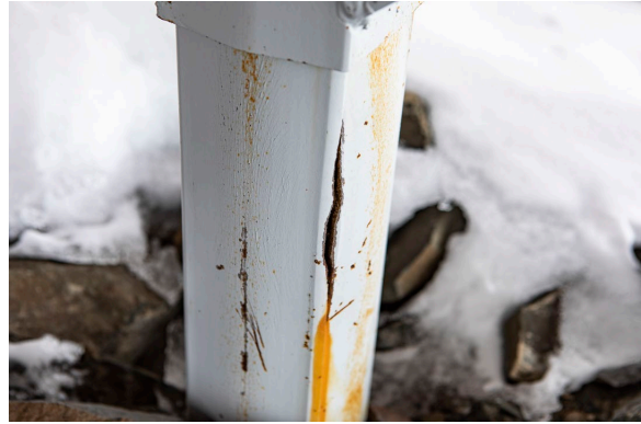
Figur B6-6. Spricka i bärande stålprofil som uppkommit av att drivsnö omväxlande tinat och frusit.
