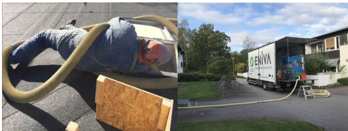
Figur 2. Bilder från genomförandet av isoleringsarbetena
