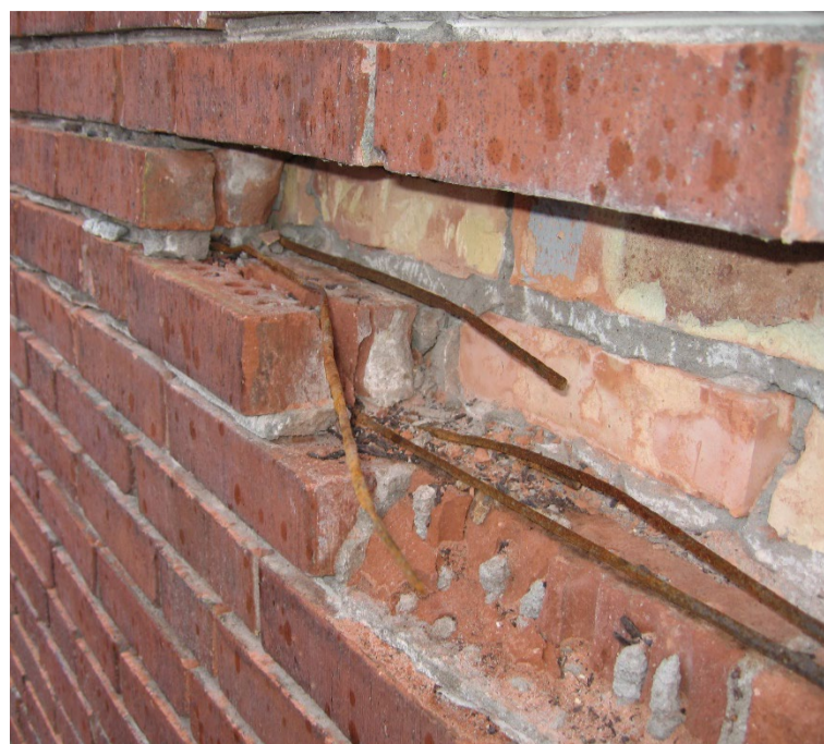
Korroderande armering
